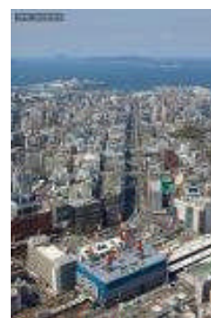
工事中の博多駅 (提供 福岡市)
